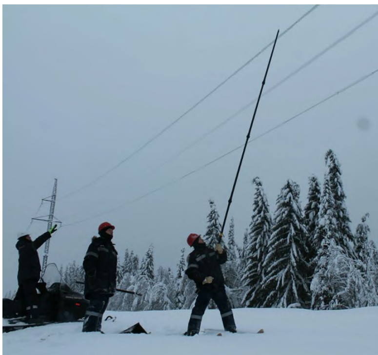
Рисунок 2 – Механическая очистка ЛЭП от льда
